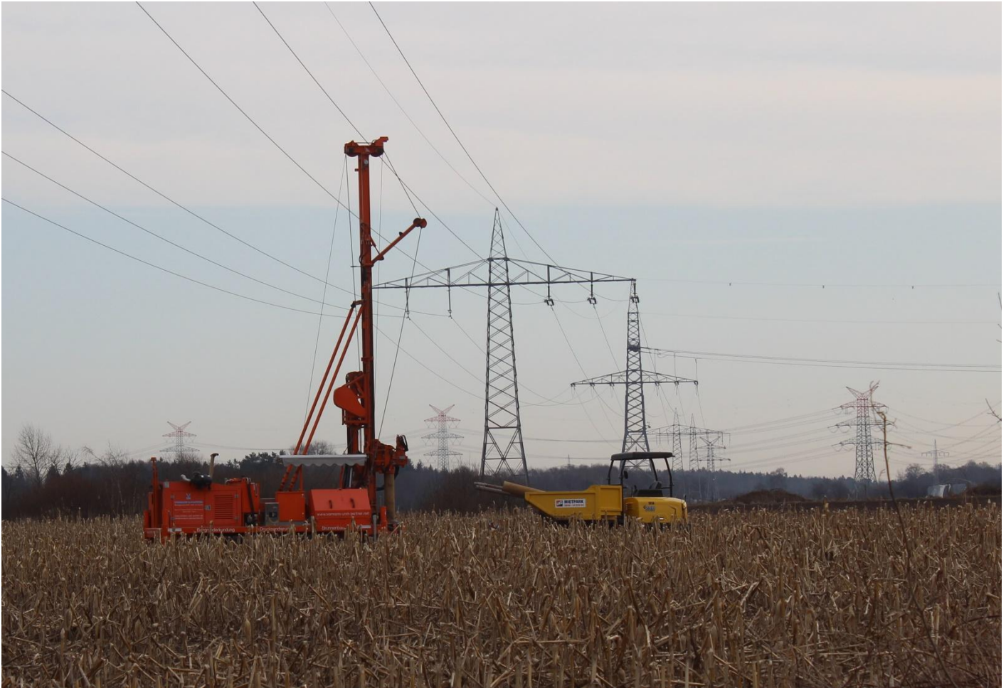
Testbohrung auf einer Fläche zwischen Feerner Moor und geplantem Surfpark
